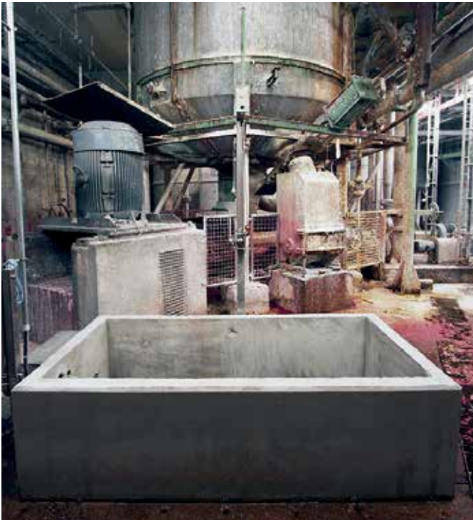
Papierwerke Lenk groundwater collector
